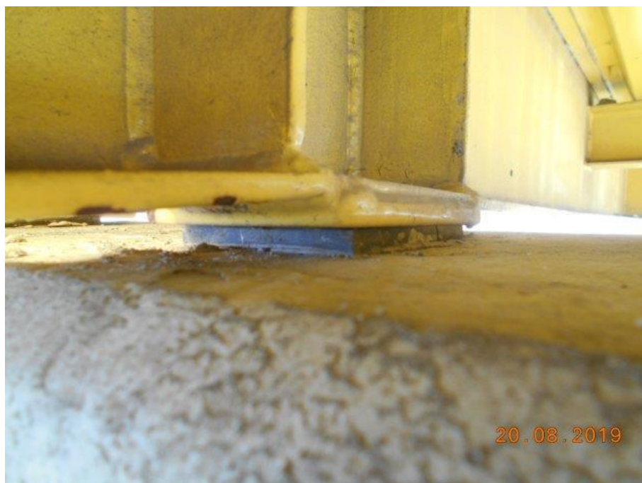
Foto 14 Aparelho de apoio AA3 em bom estado.
