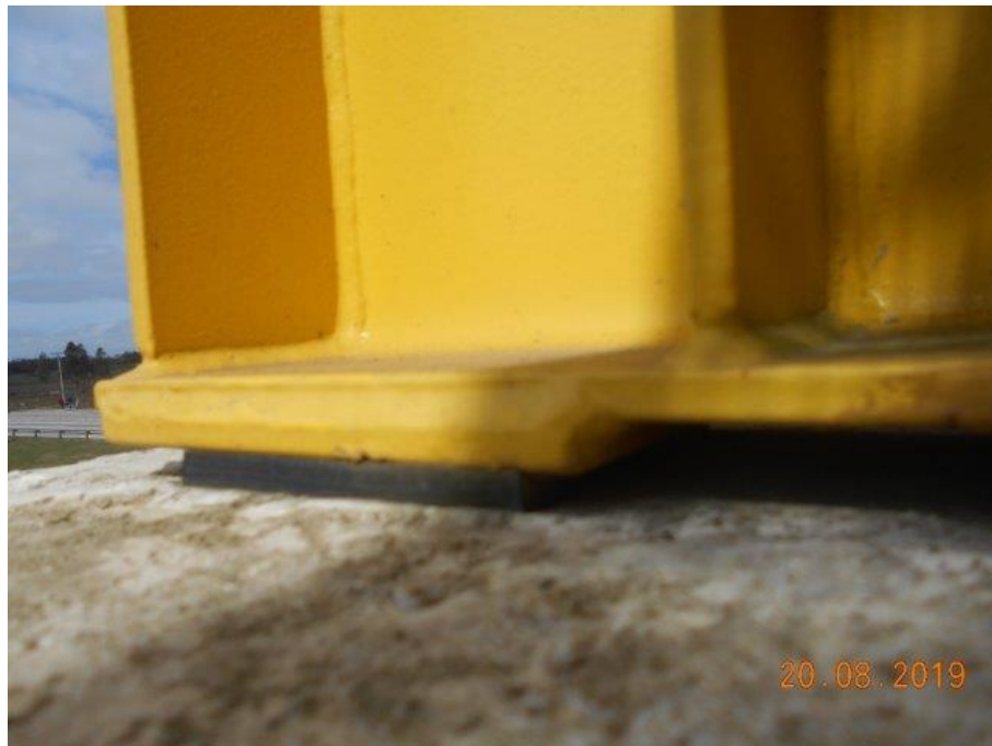
Foto 31 Aparelho de apoio AA41 em bom estado.
