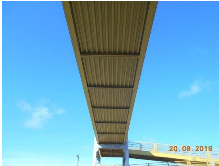
Foto 11 Vista inferior da travessia principal.
