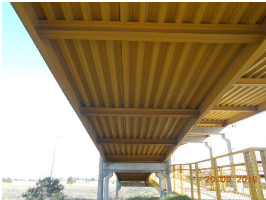
Foto 10 Vista inferior da rampa Oeste.
