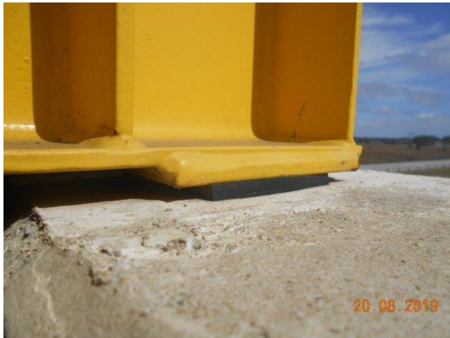
Foto 33 Aparelho de apoio AA45 em bom estado.
