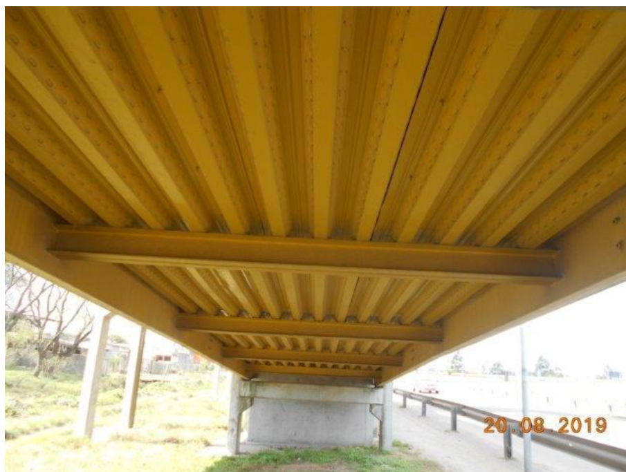
Foto 12 Vista inferior da rampa Leste.
