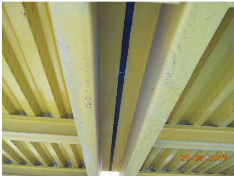
Foto 46 Vista da junta entre o patamar do vão 1 com o vão 2.
