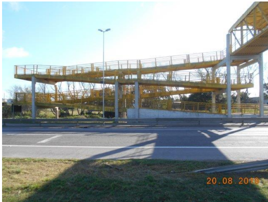
Foto 09 Vista frontal e dos apoios da rampa Leste.
